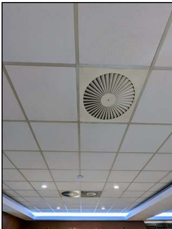
Une bouche de ventilation servant au traitement d'air de confort (soufflage) de la « salle de restaurant/scramble » et à l'extraction des fumées en mode désenfumage mécanique
