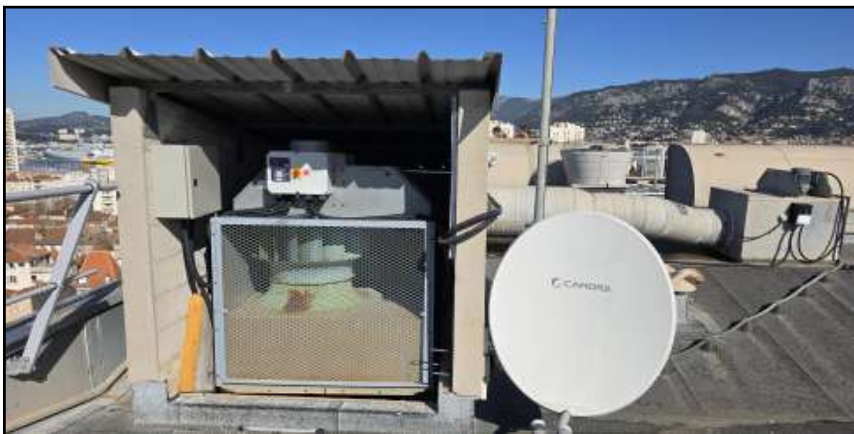
Edicule de la toiture (plancher haut du 6 ème étage) du bâtiment bleu accueillant le caisson de désenfumage mécanique du « restaurant/scramble »
