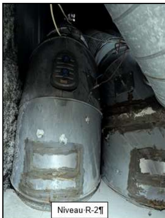
Gaine technique maçonnée accueillant différents conduits verticaux (désenfumage mécanique, hottes de la cuisine, conduits et canalisations non identifiés et inconnus, etc.) entre le niveau « R-2 » et le niveau « R+6 » du bâtiment bleu
