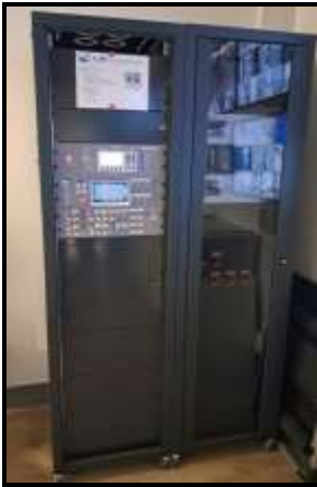
Centrale incendie au PC du bâtiment bleu
