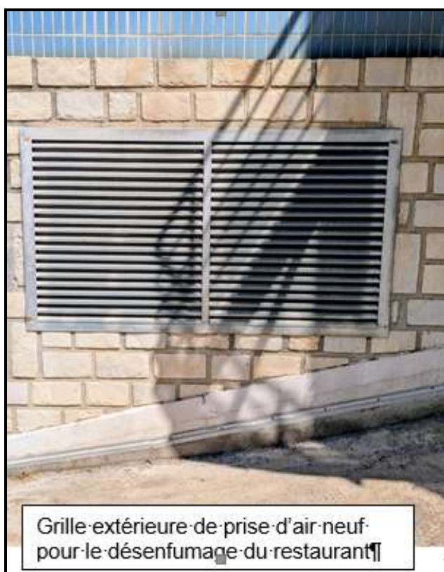
Prise d'air extérieure et amenées d'air mal réparties
