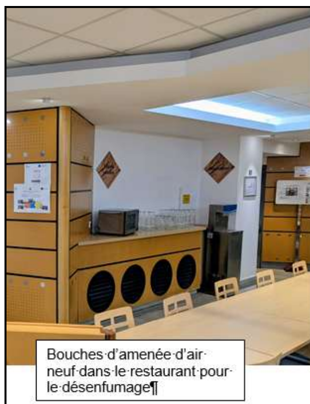
Prise d'air extérieure et amenées d'air mal réparties
